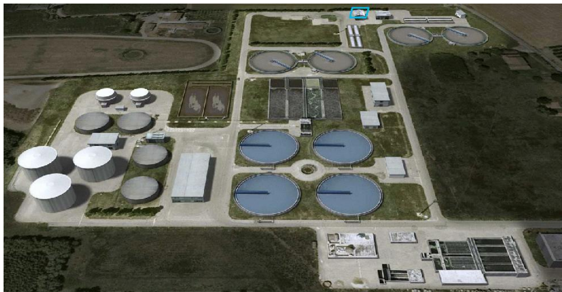
Figura 5. 3. Immagine aerea del depuratore di Santa Giustina
