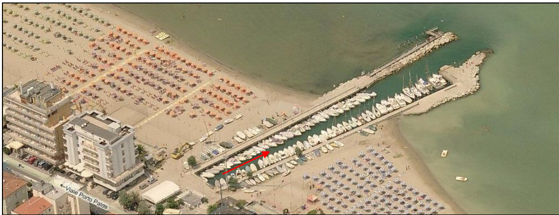
Figura 5.18. Vista aerea dell'uscita della Fossa Sortie
