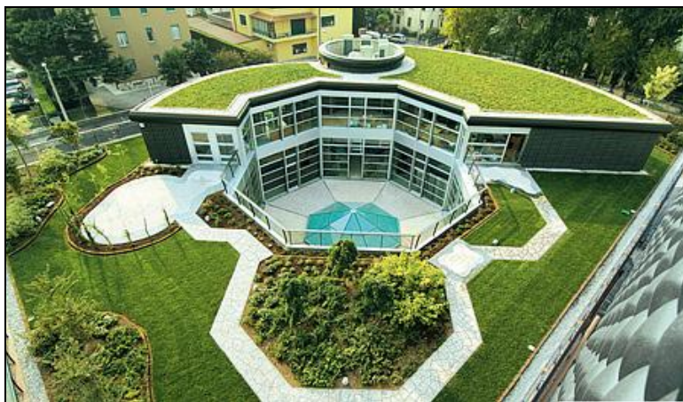
Figura 3.6 – Esempio di un tetto verde [ http://immobiliedintorni.wordpress.com ]
