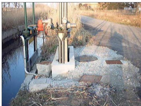
Figura 5.10. Schema delle paratoie della fossa Torre Pedrera Grande (Manuale di conduzione Hera)
