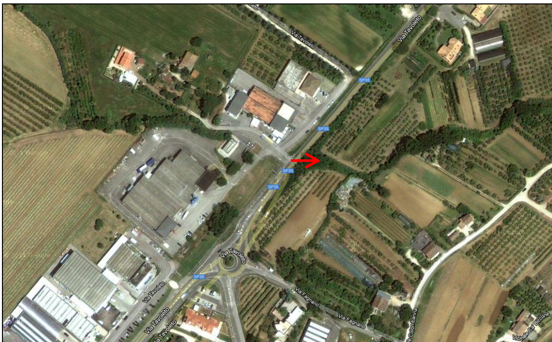
Figura 10.38. Immagine aerea della posizione dello SFAM 501 BIS in Comune di San Clemente su cui intervenire per la gestione delle acque di prima pioggia.
