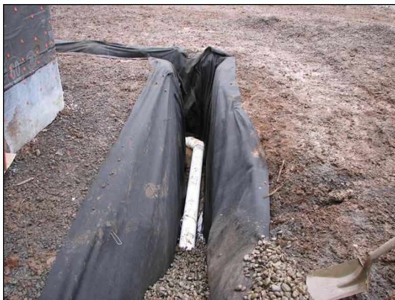
Figura 3.10 – Fase di posa in opera di una tubazione drenante [ http://www.drainagemasters.com ]
