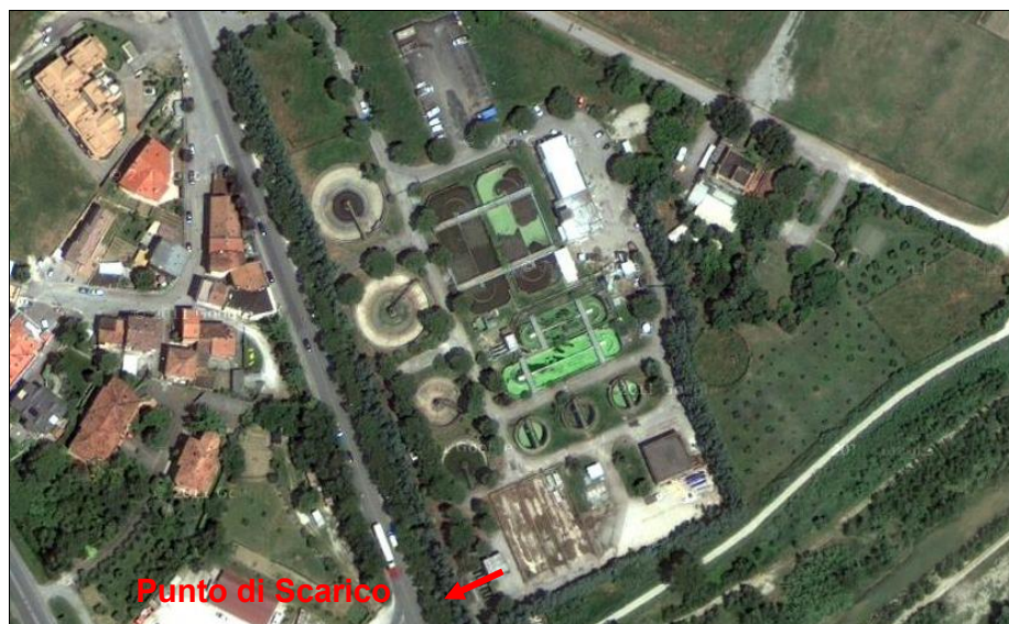
Figura 10.10. Vista aerea del depuratore di Misano.
