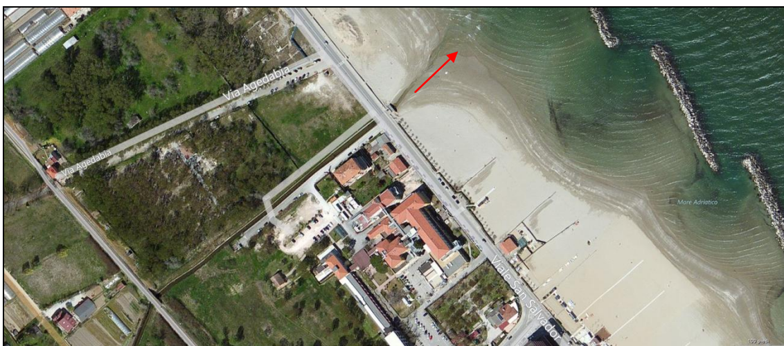
Figura 5.9. Vista aerea della Fossa Torre Pedrera
