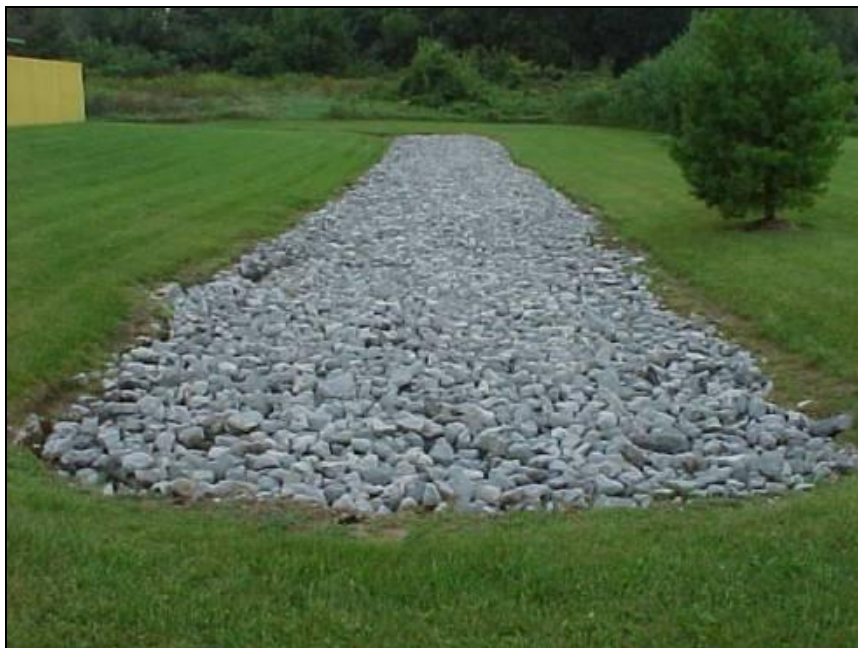
Figura 3.15 – Esempio di canale filtrante [ http://www.washco-md.net ]
