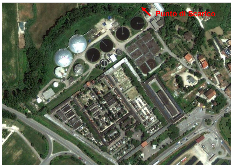
Figura 10.9. Vista aerea del depuratore di Cattolica.
