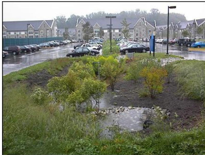
Figura 3.26 – Bacino d'infiltrazione realizzato in un parcheggio pubblico [http://155.247.107.222/tvssi]
