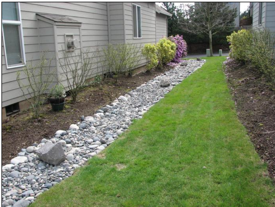
Figura 3.11 – Violetto in ciottoli che nasconde una tubazione drenante [ http://www.homeownercare.com ]
