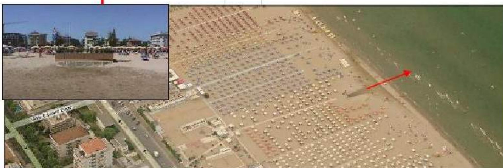
Figura 5.41. Immagine aerea del punto di scarico del Colonnella I
