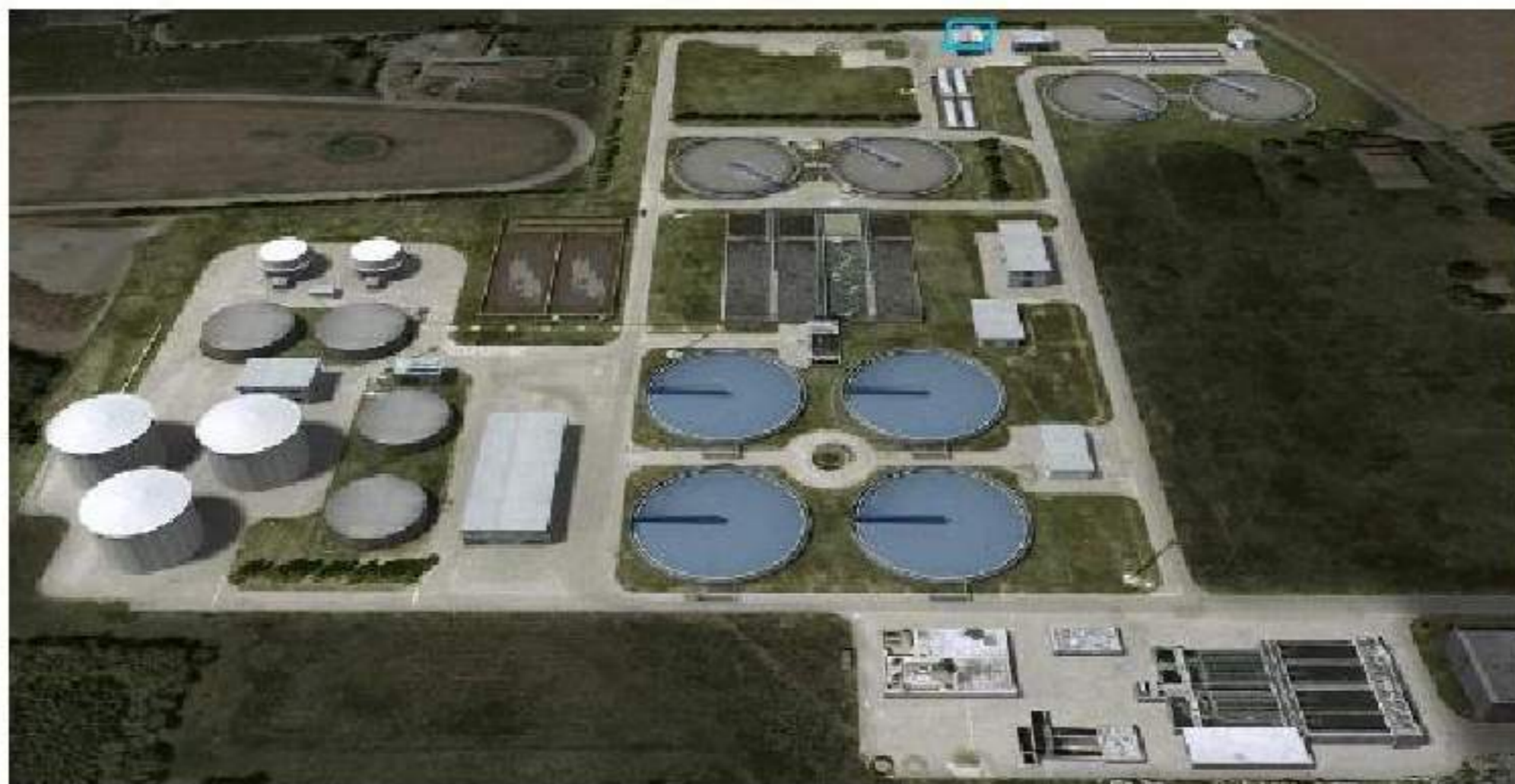
Figura 5. 3. Immagine aerea del depuratore di Santa Giustina
