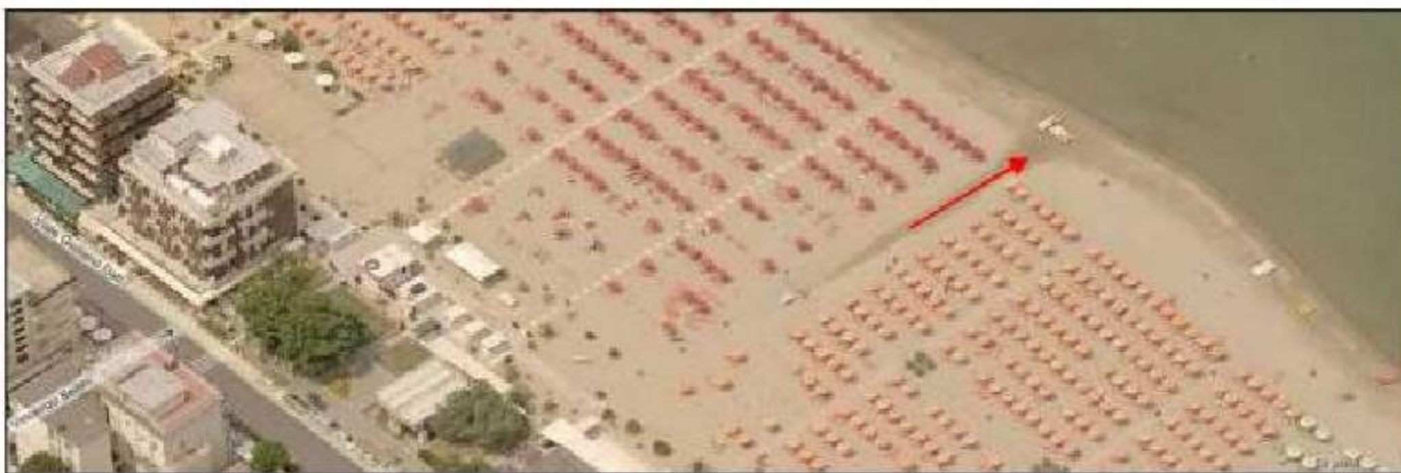
Figura 5.20a. Vista aerea dell'uscita della Fossa Spina
