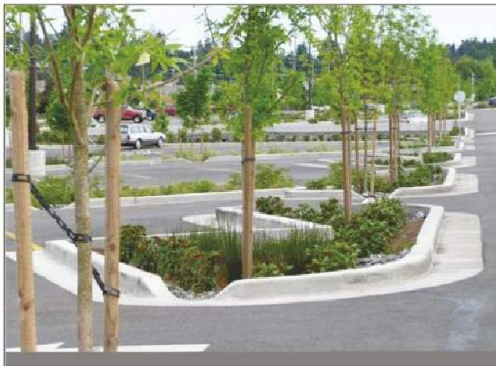
Figura 3.34 – Infiltration planters all'interno di un parcheggio pubblico [ http://olsonplanning.com ]
