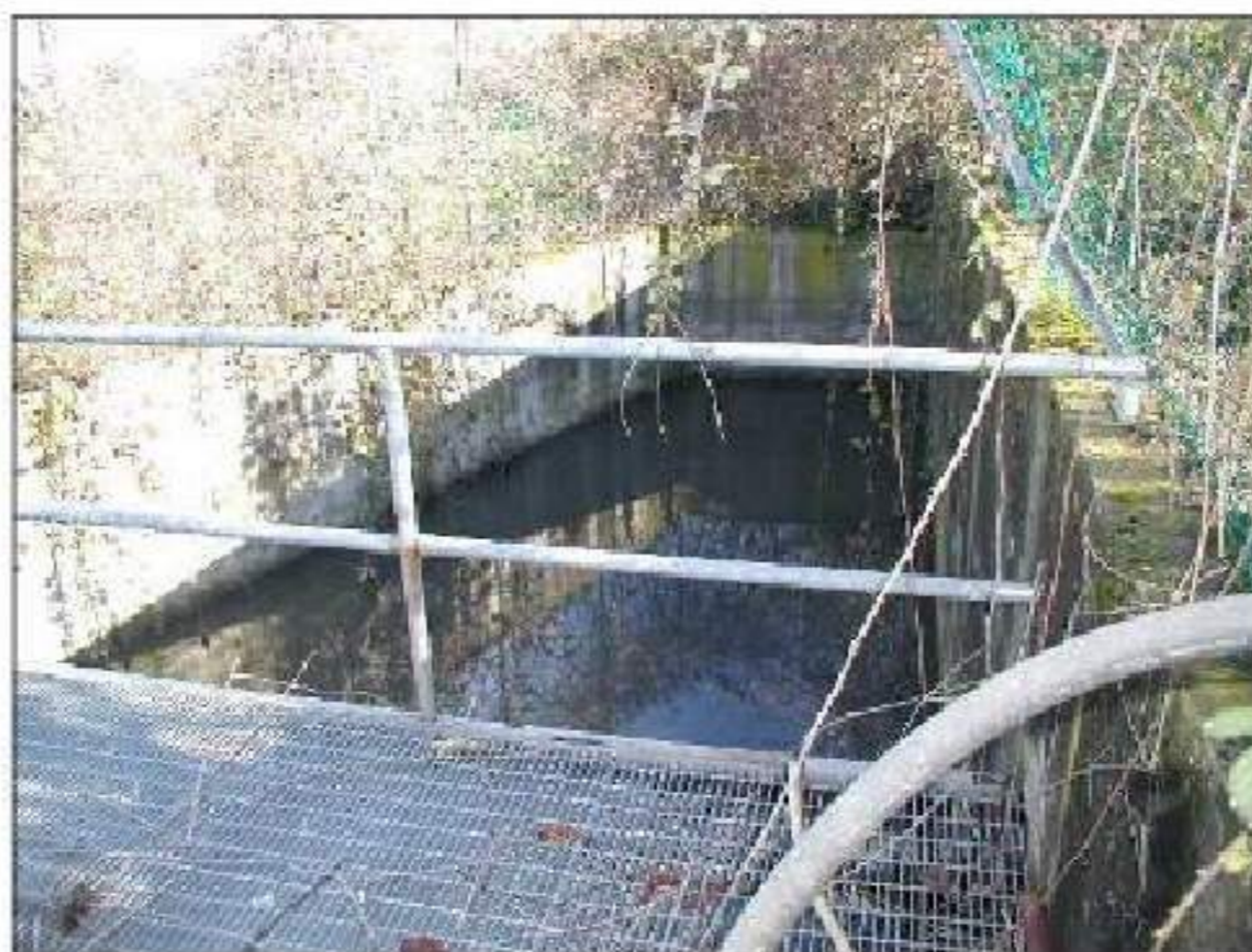
Figura 10.24 Vasca di Accumulo presso sollevamento Abbazia
