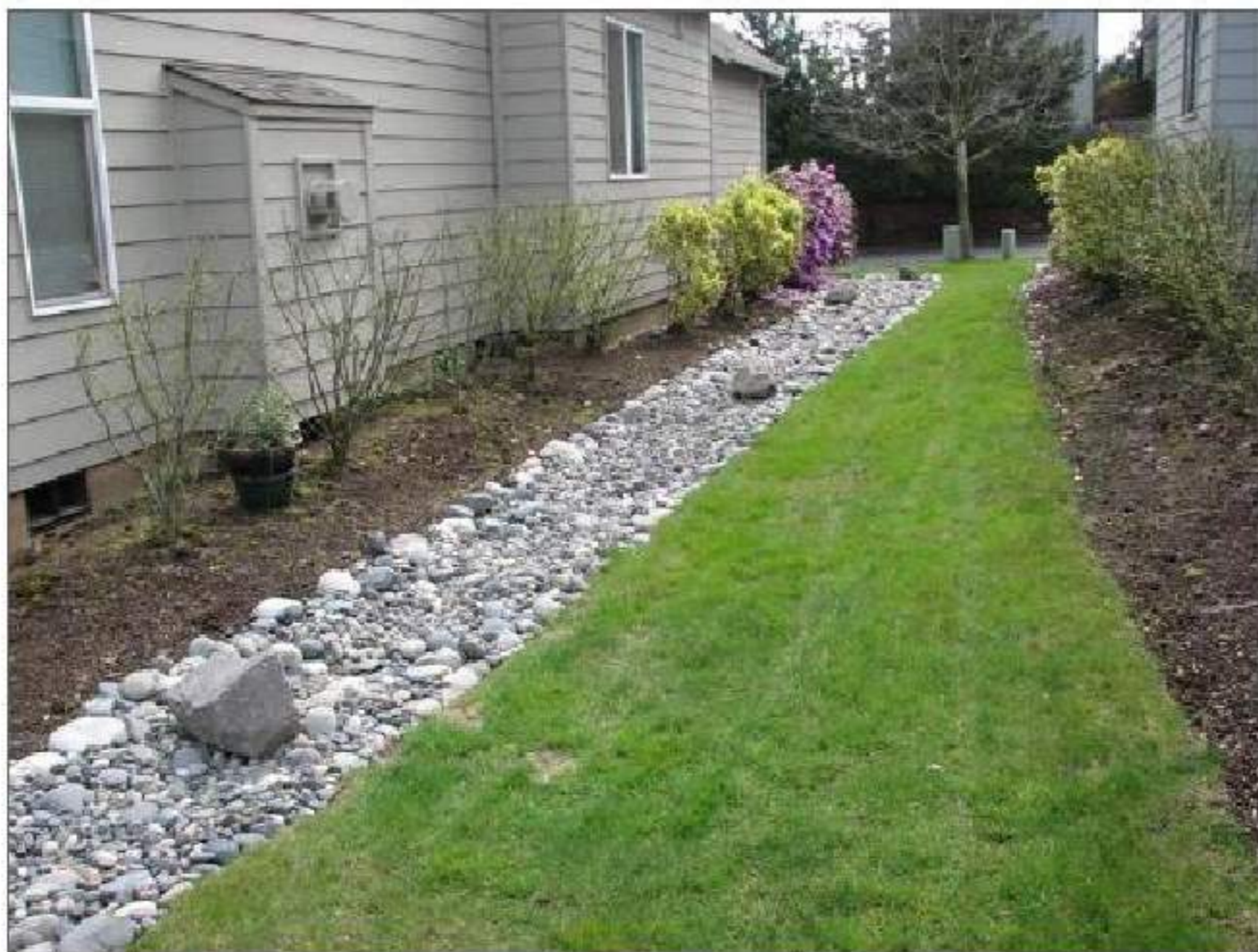
Figura 3.11 – Vialetto in ciottoli che nasconde una tubazione drenante [ http://www.homeownercare.com ]
