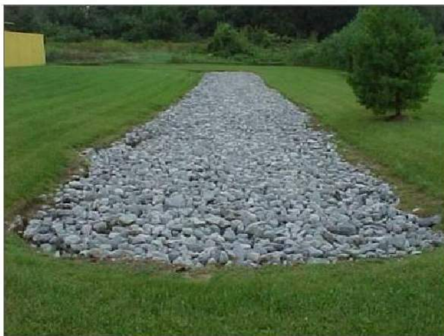
Figura 3.15 – Esempio di canale filtrante [ http://www.washco-md.net ]
