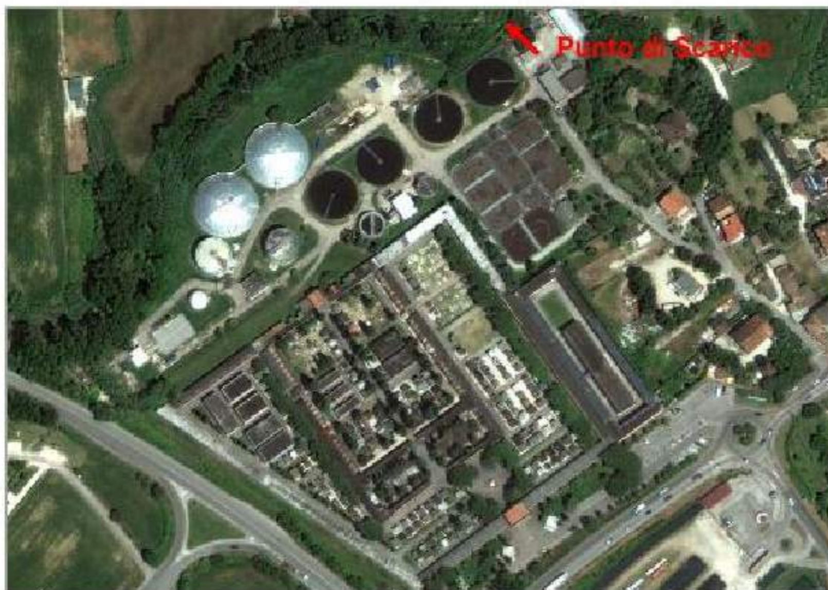
Figura 10.9. Vista aerea del depuratore di Cattolica.
