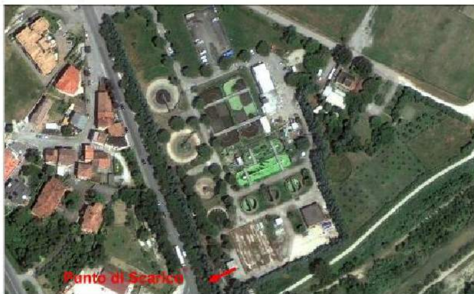
Figura 10.10. Vista aerea del depuratore di Misano.
