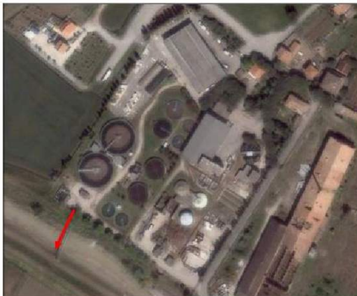
Figura 5.57. Depuratore Comune di Bellaria con la rappresentazione del punto di scarico.
