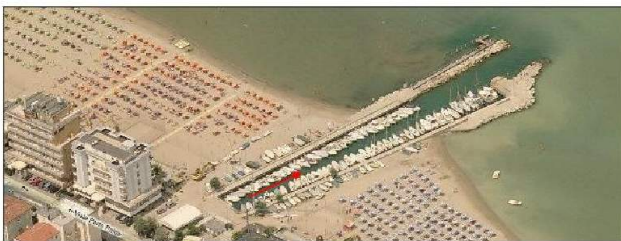
Figura 5.18. Vista aerea dell'uscita della Fossa Sortie
