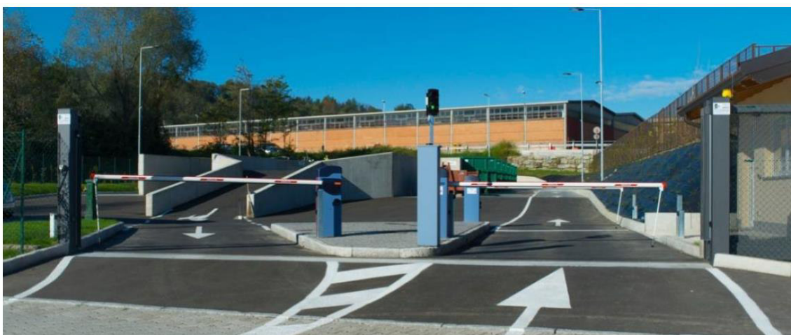
Ingresso di centro di raccolta informatizzato, con sbarre di accesso e uscita
