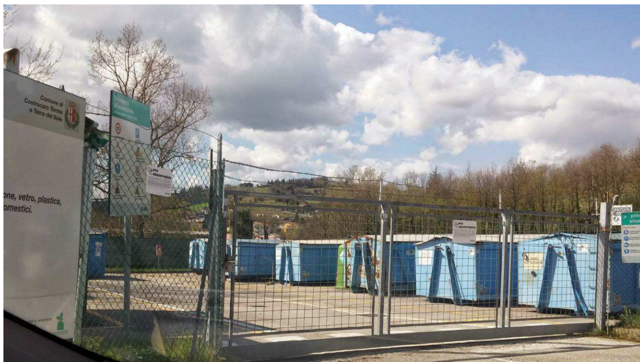
Fig. 3.40 – Esempio di stazione ecologica
