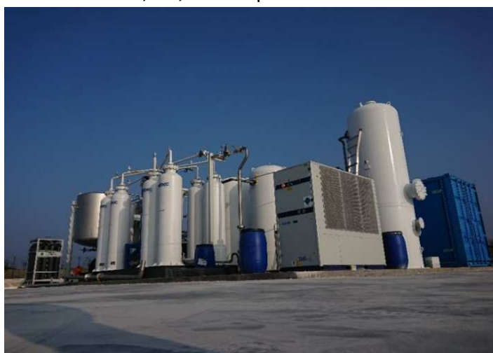
Figura 9: sezione di upgrading.
